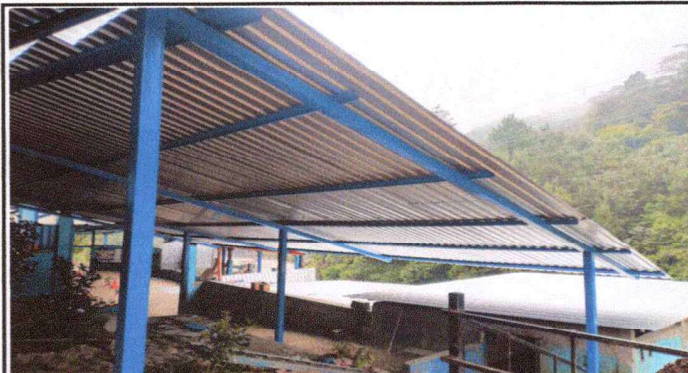
Foto 2: Trabajo terminado de colocación de lamina en el modulo 2
