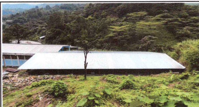
Foto 1: Terminación de la colocación del nuevo techo del modulo 1
