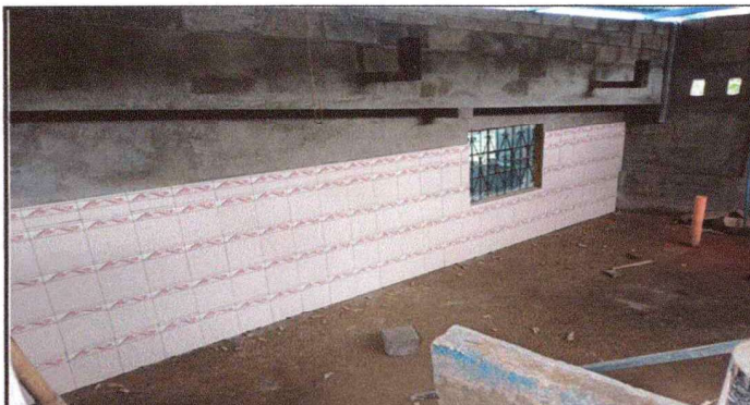
Foto 4: termino de los trabajos realizados en la cocina modulo 2
