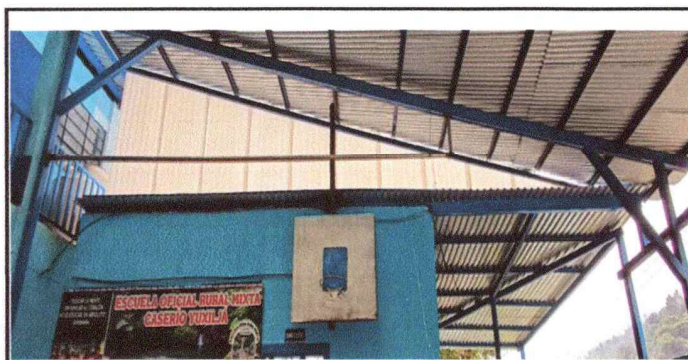
Foto 6: Vista desde el interior del modulo 3 donde se muestra la conclusión de los trabajos de cambio de entchado
